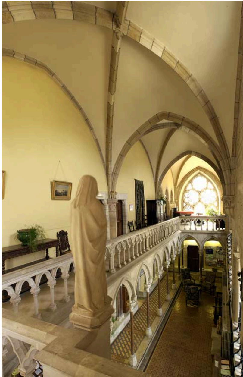
Bâtiment du réfectoire : partie sud du bâtiment (aménagement néo-gothique) : galeries basse et haute et vestibule (vue prise depuis le nord).
