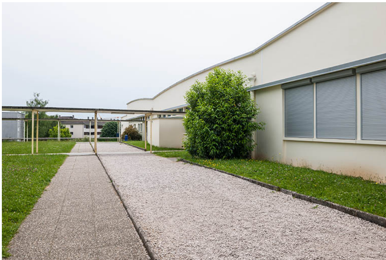
Passages entre Ateliers et externat.
