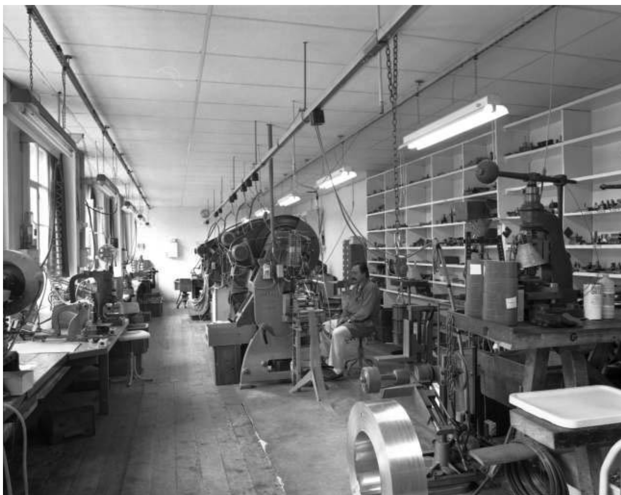
Intérieur de l'atelier au rez-de-chaussée.
