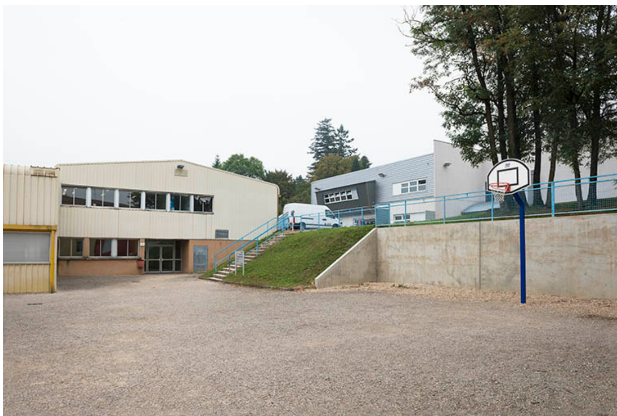
Ateliers : façade sud.
