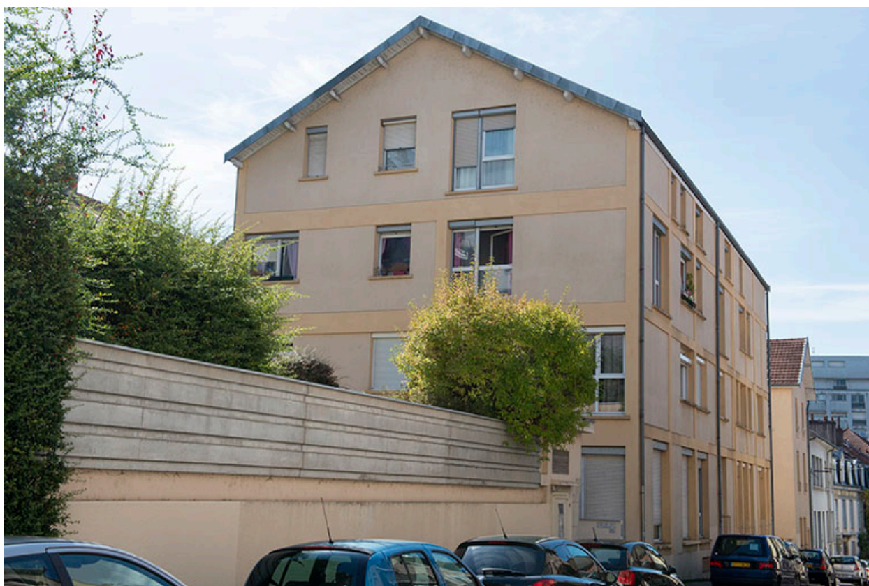
Vue depuis le nord.
