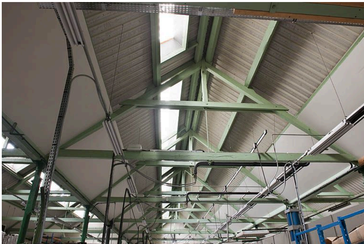
Charpente de l'atelier de finition.
