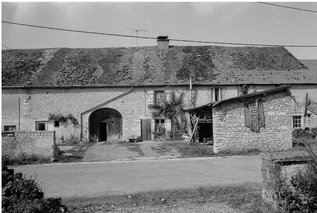
Ferme située Grande Rue (près du lavoir).
