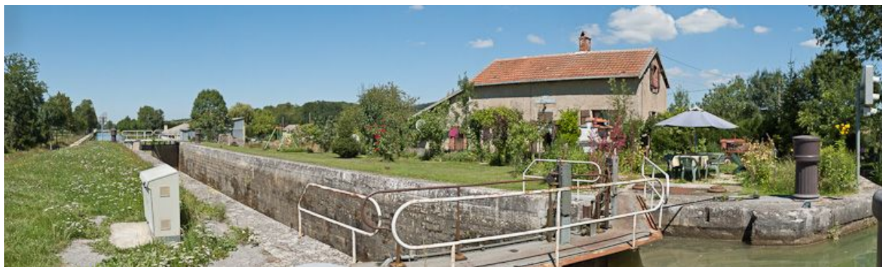
Vue d'ensemble du site d'écluse.
