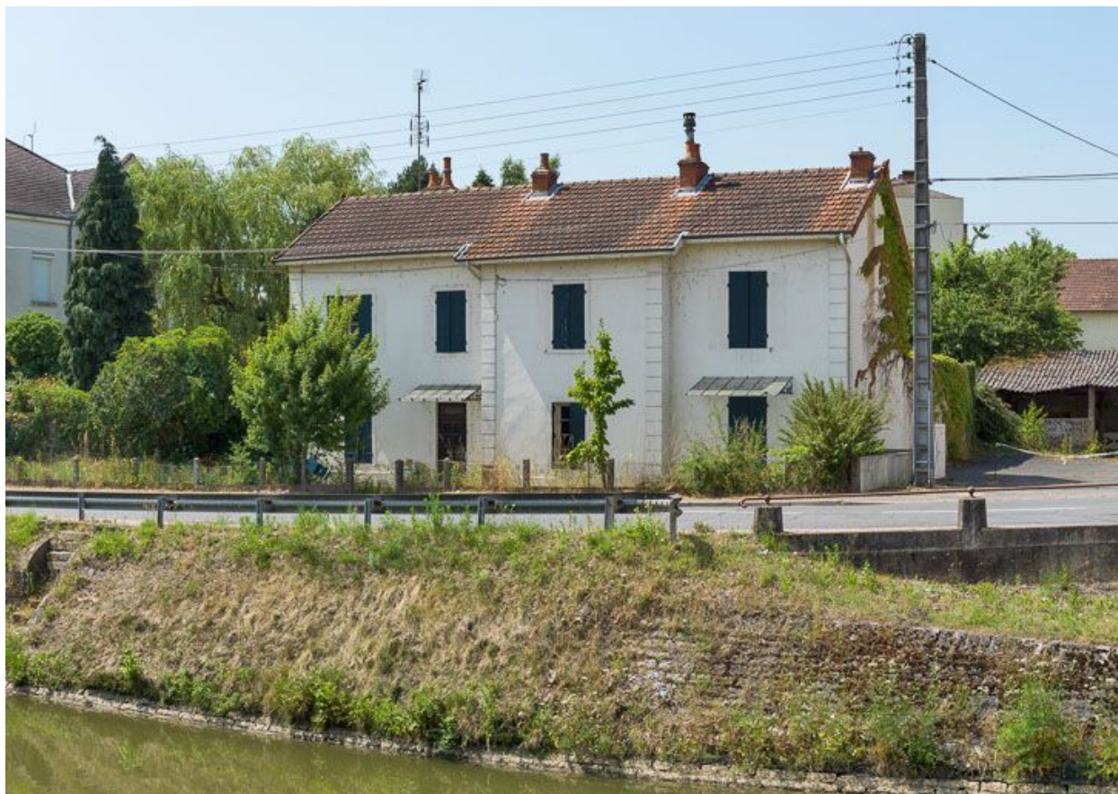
Vue depuis la rive droite.
