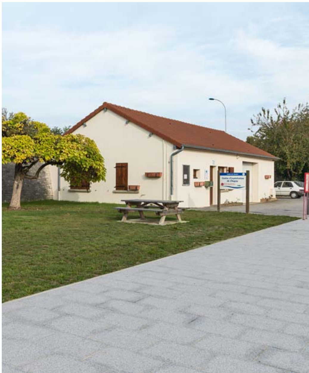
Vue d'ensemble de la maison de garde.
