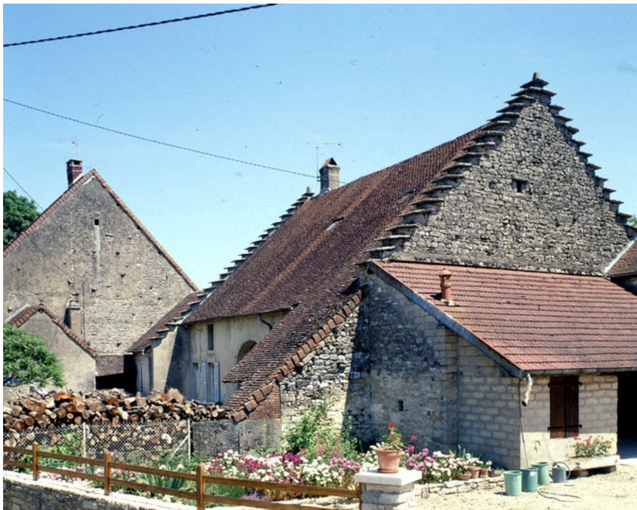
Ferme : façades latérale droite et antérieure.
