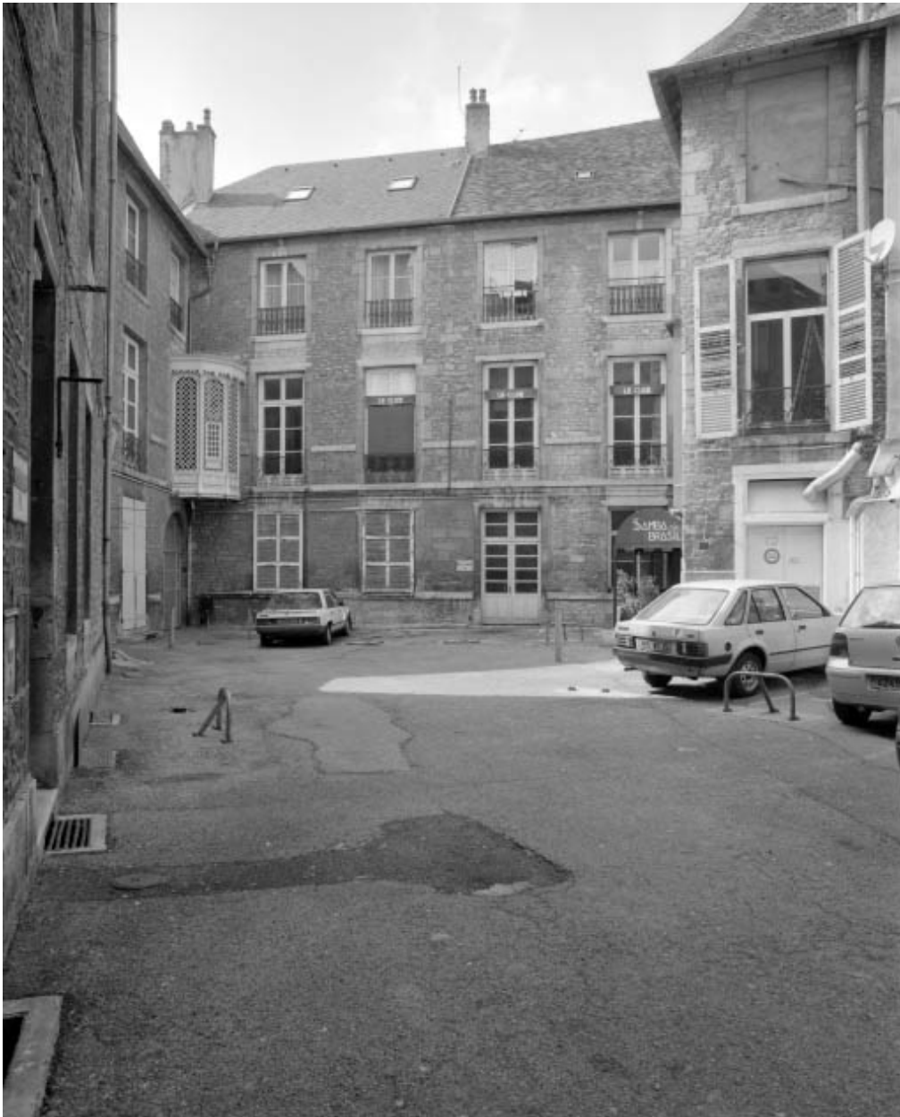
Vue d'ensemble de la façade antérieure du logis principal en fond de cour.
