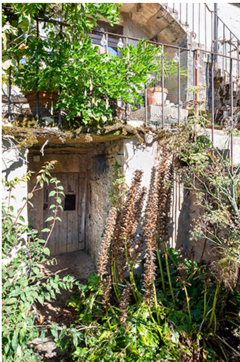
L'entrée du cellier servant de fruitier, sous l'entrée du rez-de-chaussée, côté jardin.
