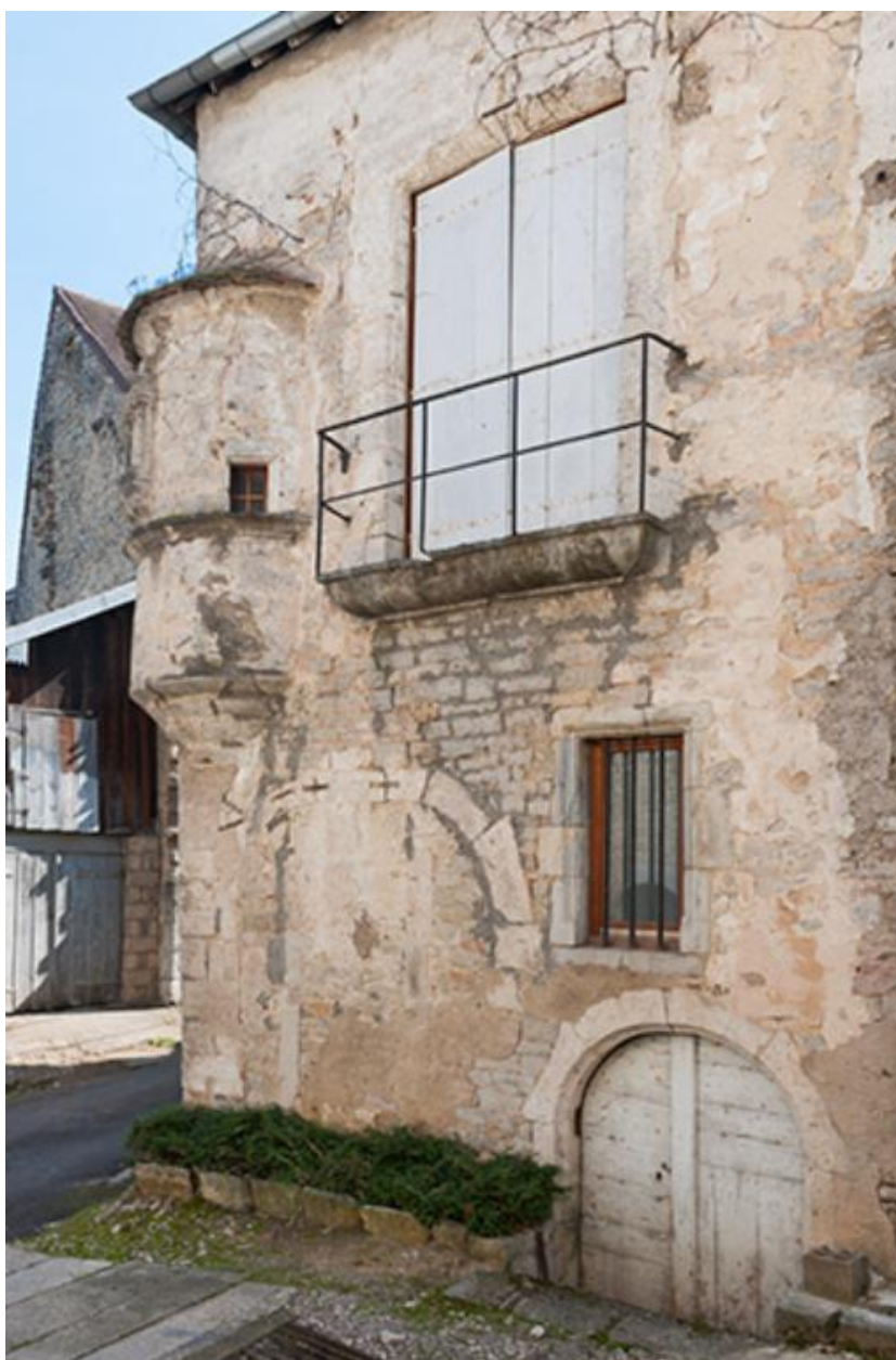
Façade nord, rue du Bourg
