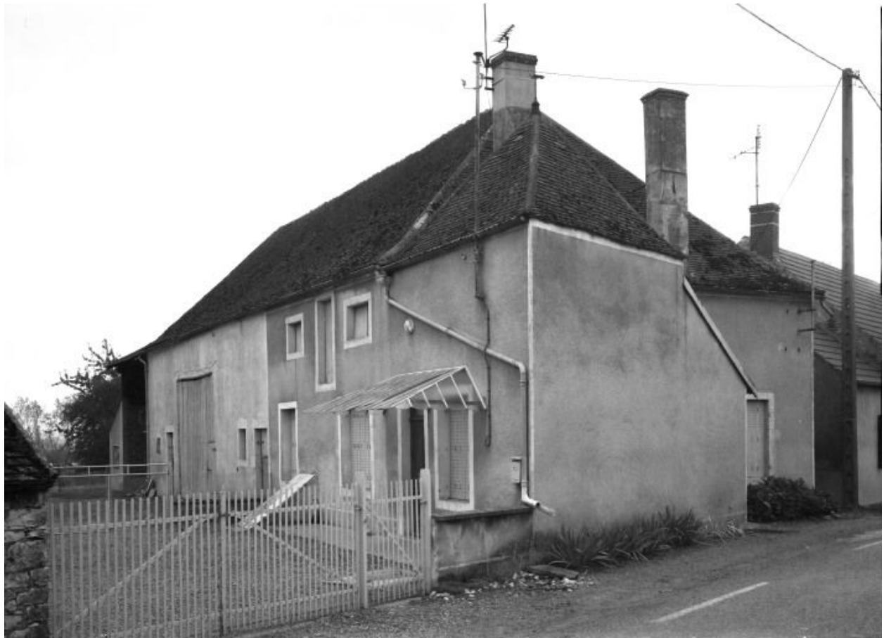
Vue d'ensemble d'une ferme (cad. 1978, sect. AO, parc. 87).
