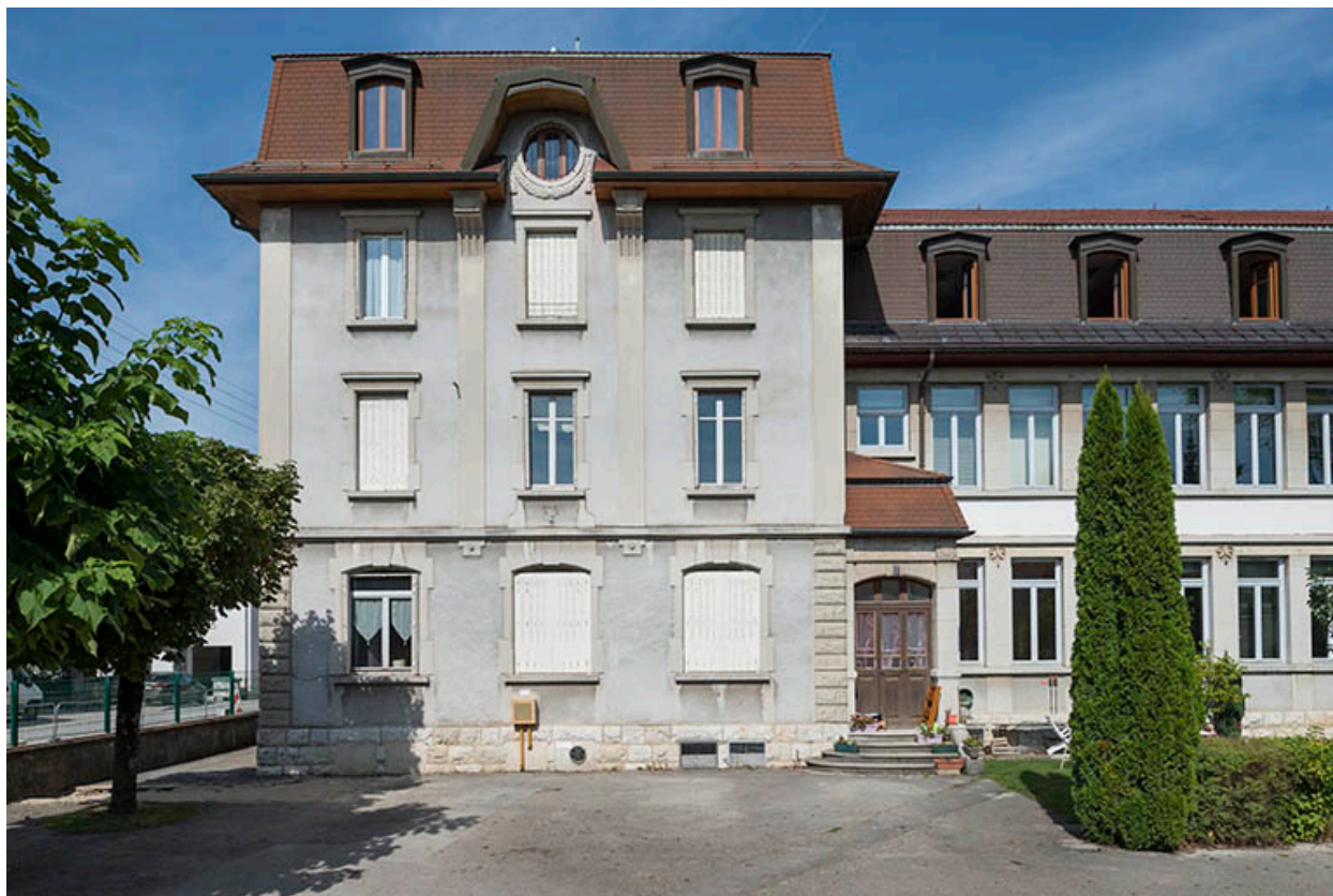
Pavillon ouest : bureau et logements.
