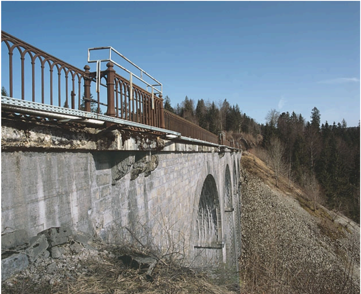
Garde-corps de l'élévation orientale.
