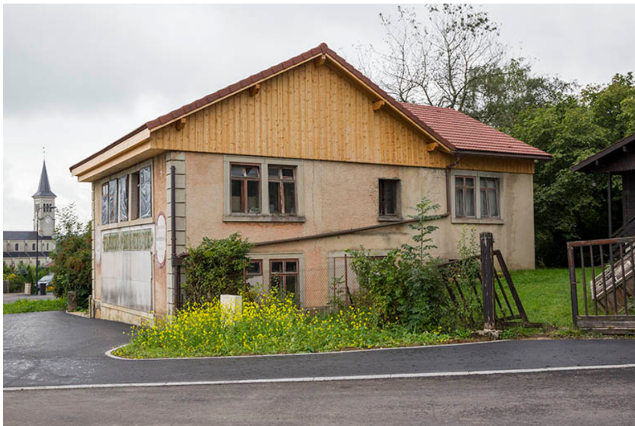
Usine : façade latérale droite (vue d'ensemble).
