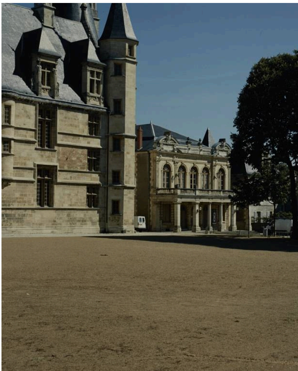
Façade et palais des ducs de Nevers, en 1996.
