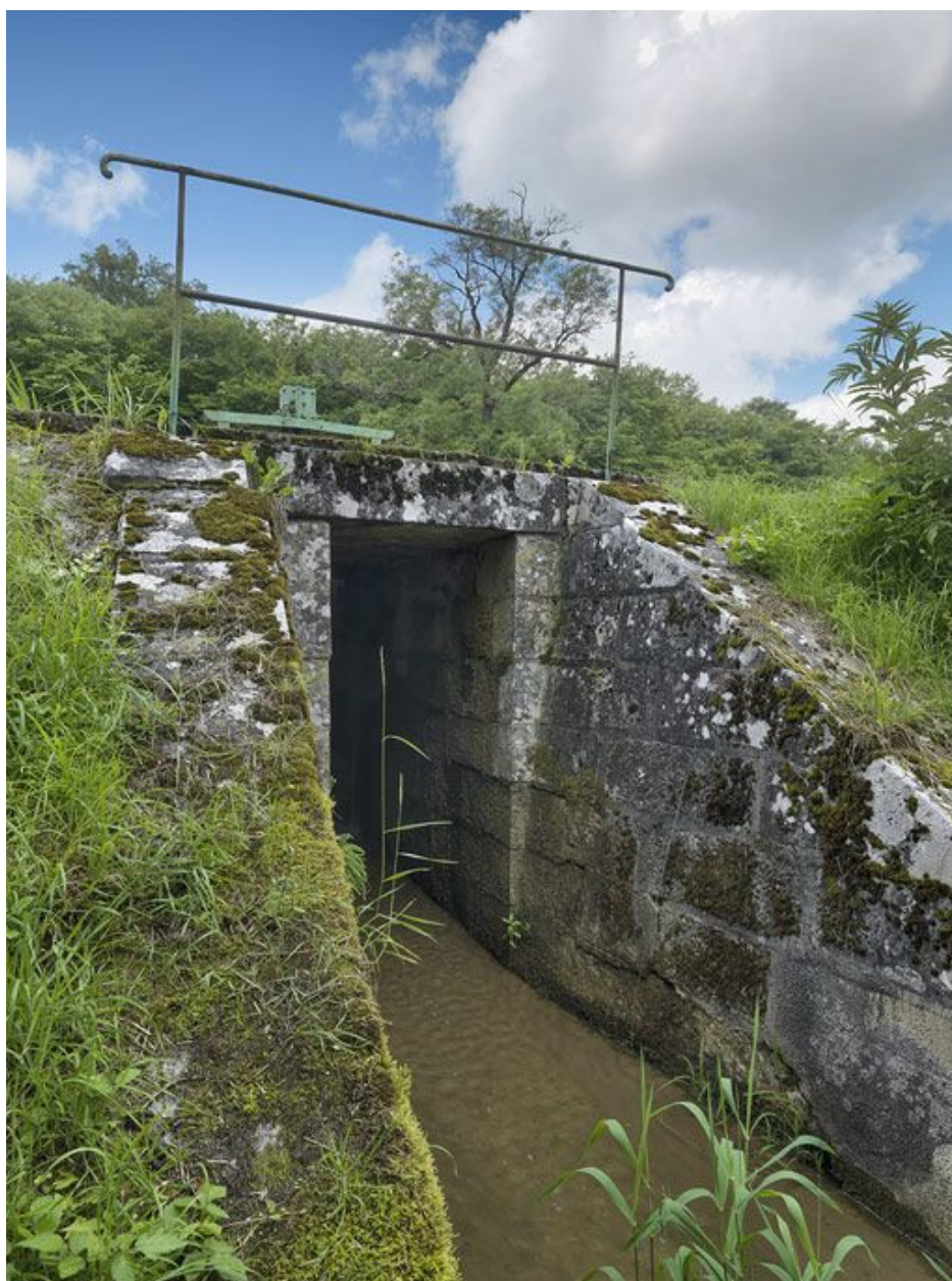
Déversoir rive gauche : sortie du déversoir.
