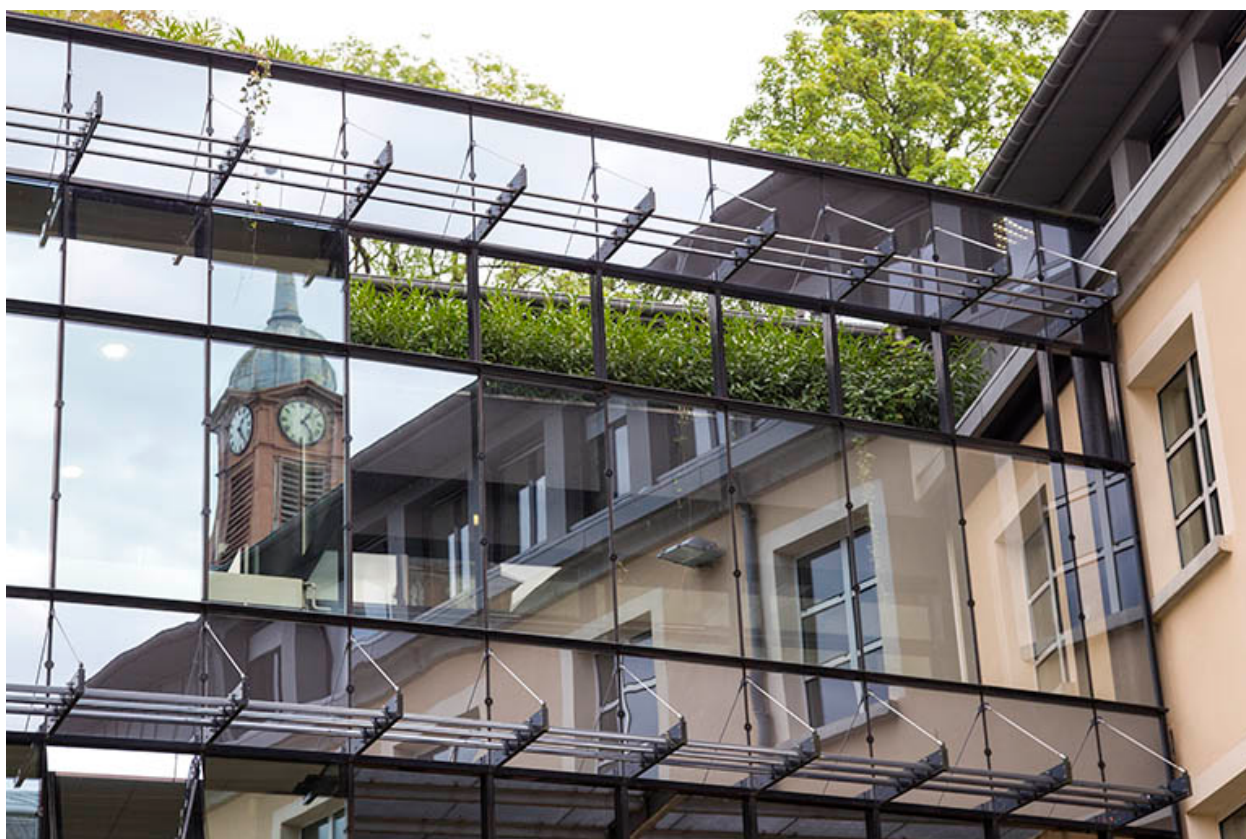
Aile Est : partie supérieure vitrée.
