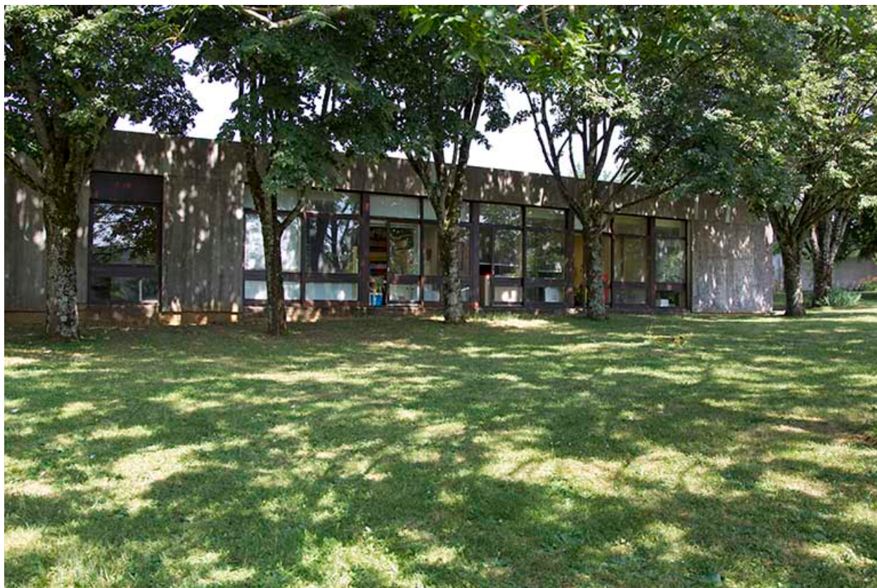
Façade postérieure - ouest - de l'administration.
