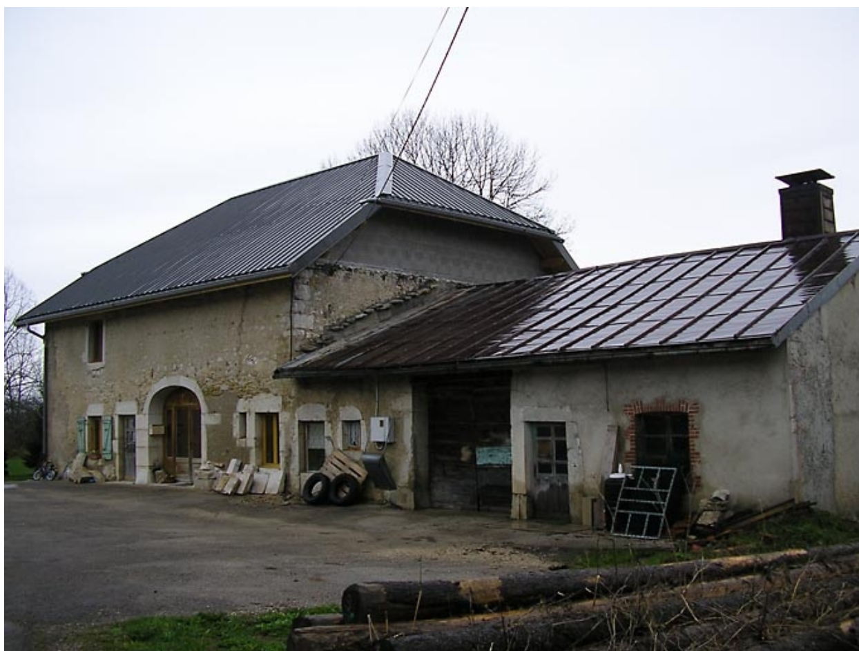
Façade antérieure vue de trois quarts.
