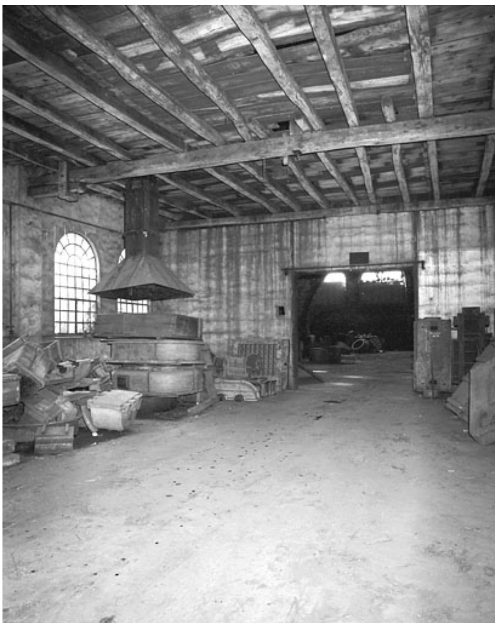
Atelier de fabrication sud en 1981.
