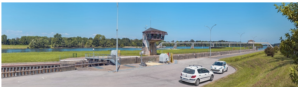
Tête aval de l'écluse et poste de commande au centre.
