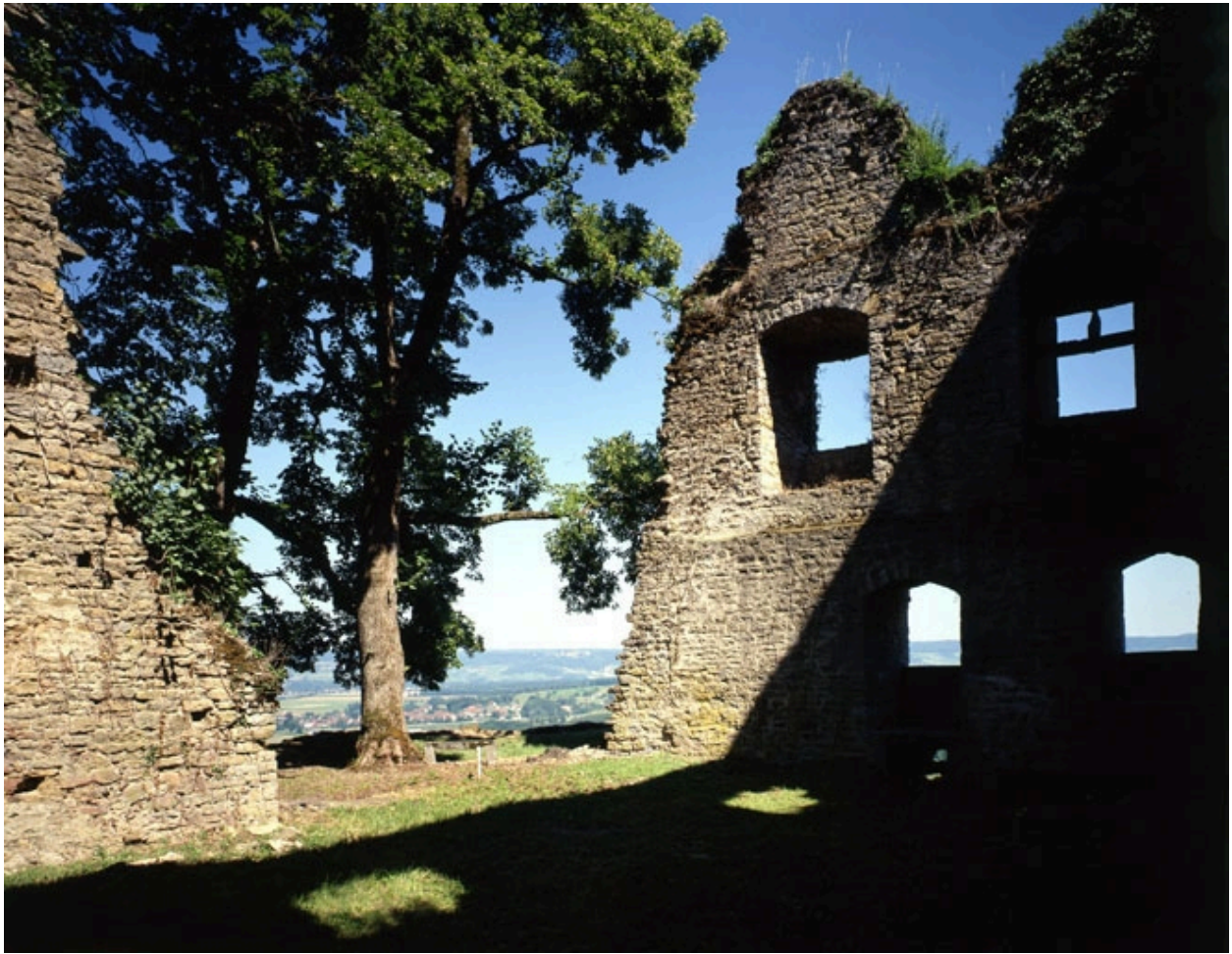
Murs du château vus de l'intérieur en 1990.
