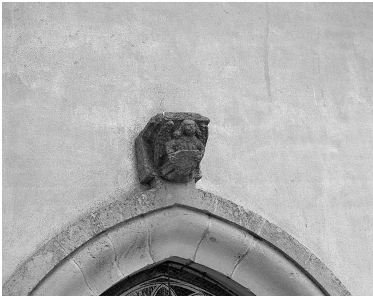
Extérieur : détail, angelot.
