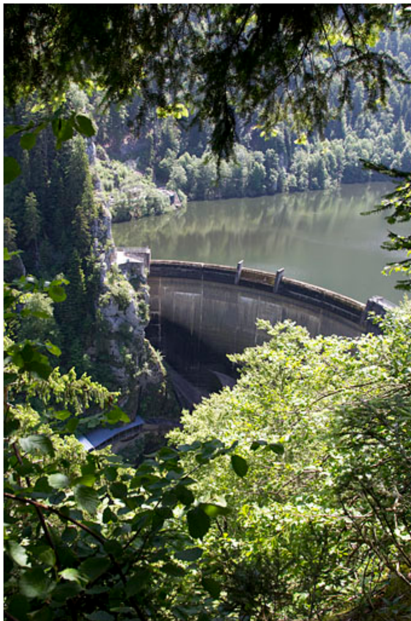
Barrage du Châtelot : vue plongeante depuis la rive gauche.
