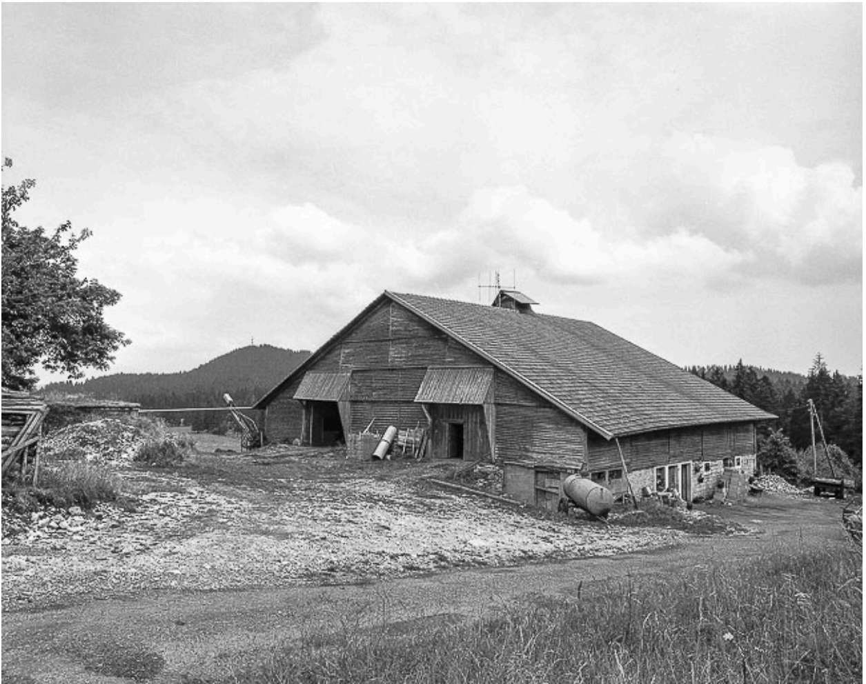
Ferme située au lieudit La Voie aux Bournez, cadastrée 1966 G2 69 : façade postérieure.
