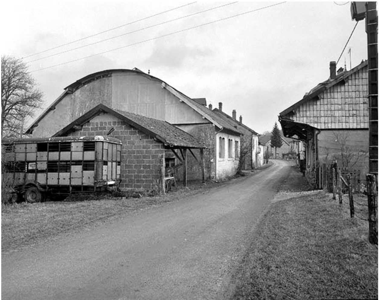
Ateliers de fabrication depuis le sud.
