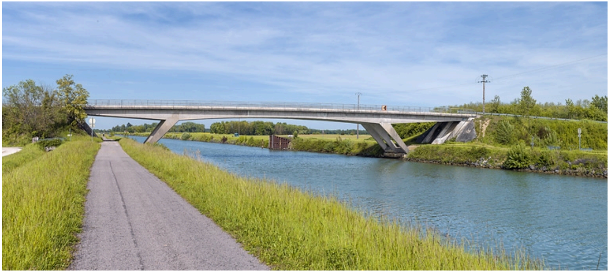
Vue d'ensemble d'amont, rive gauche.
