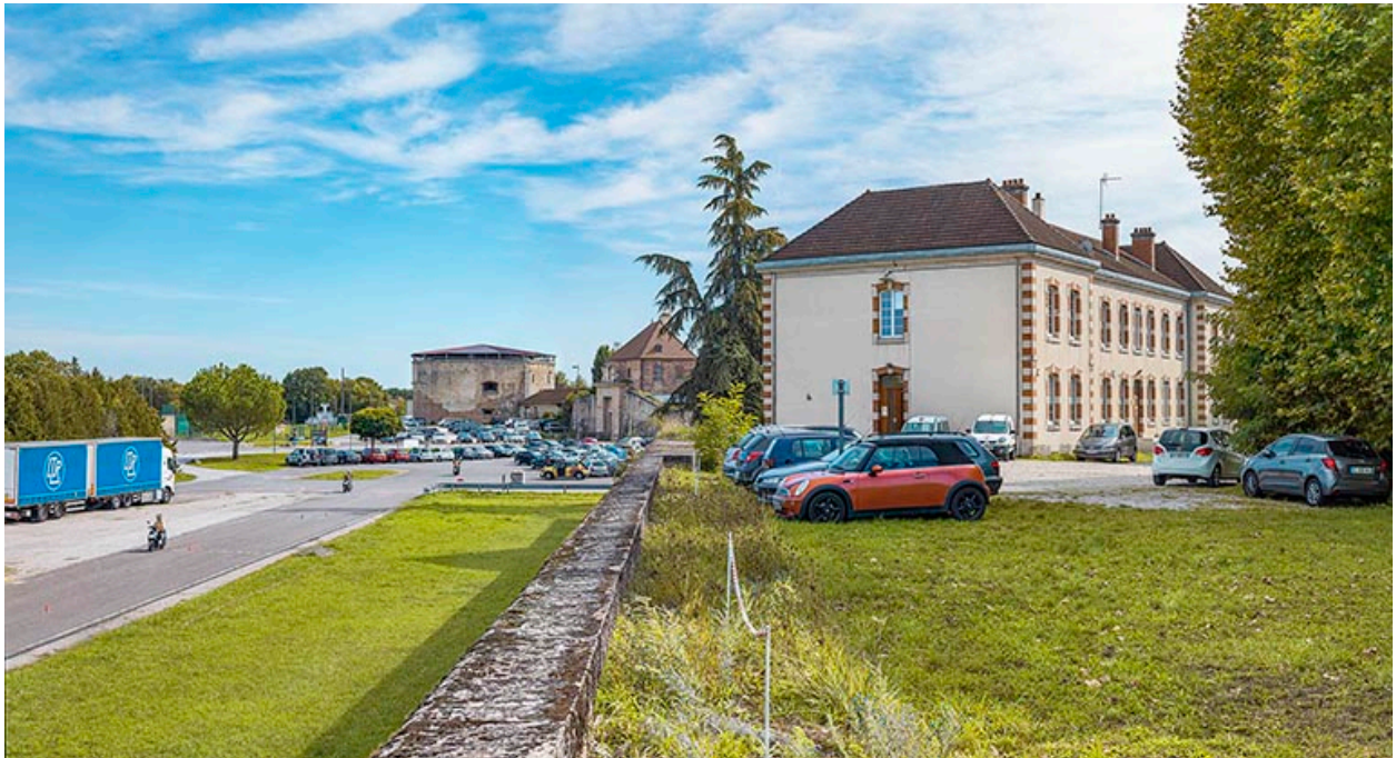
Parapet avec en arrière-plan la tour du Cygne.
