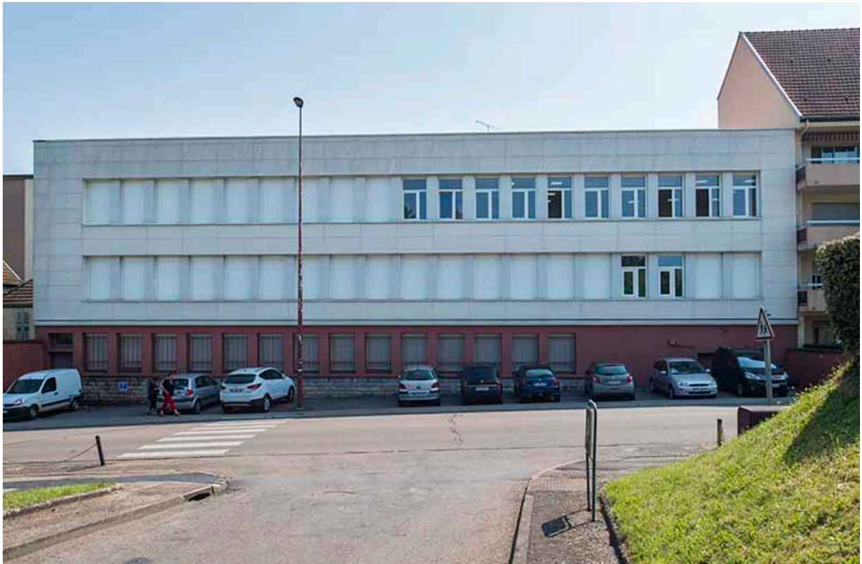
Façade postérieure ouest sur la rue de l'arsenal.
