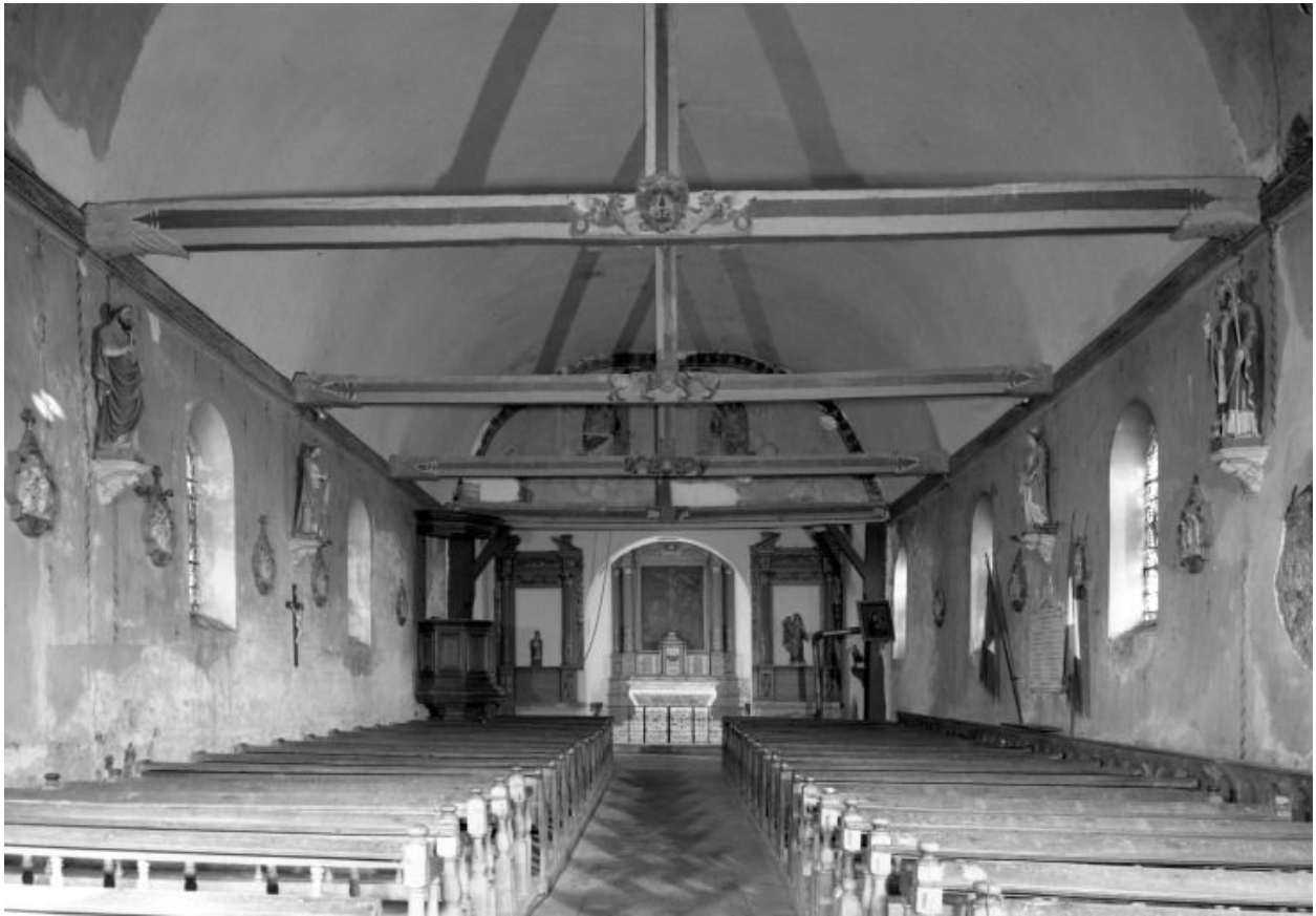
Vue intérieure prise de l'entrée
