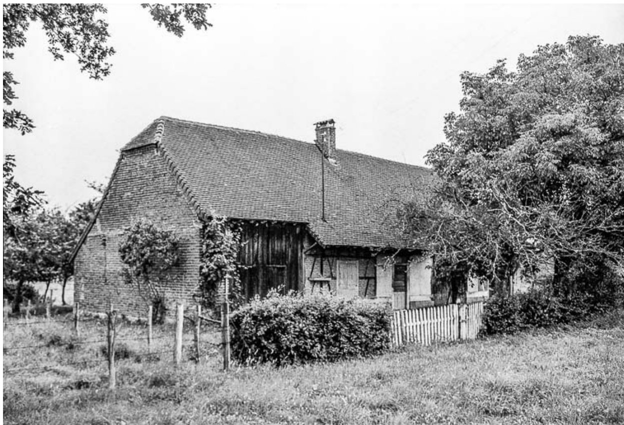
Ferme cadastrée 1969 AE 43 : façade antérieure.
