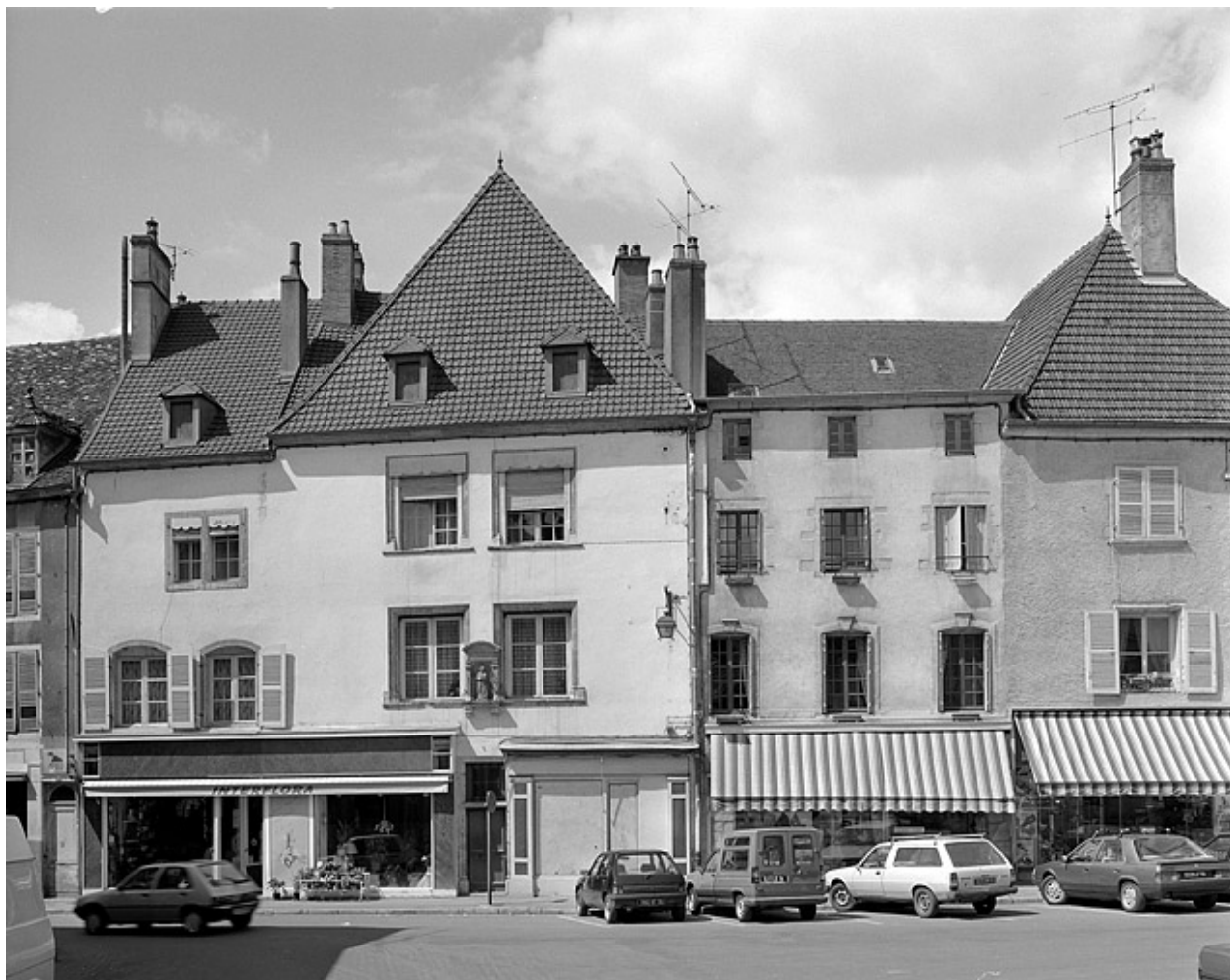
Vue d'ensemble façade antérieure, de face.
