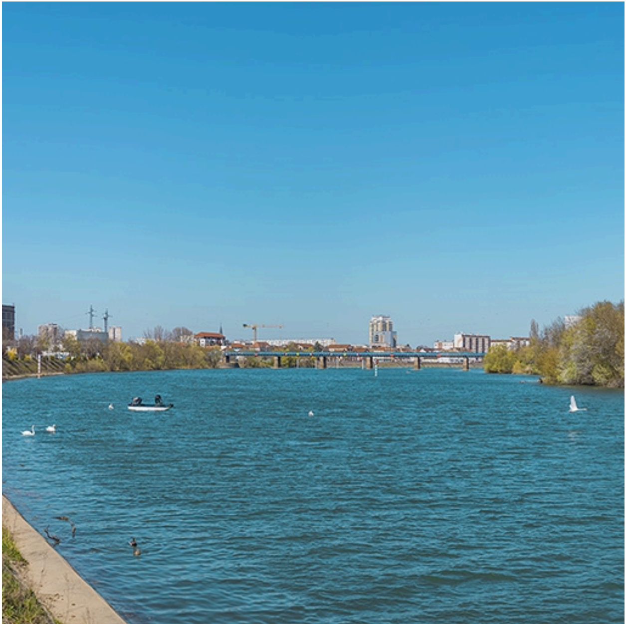
Vue d'ensemble du pont, depuis l'aval.
