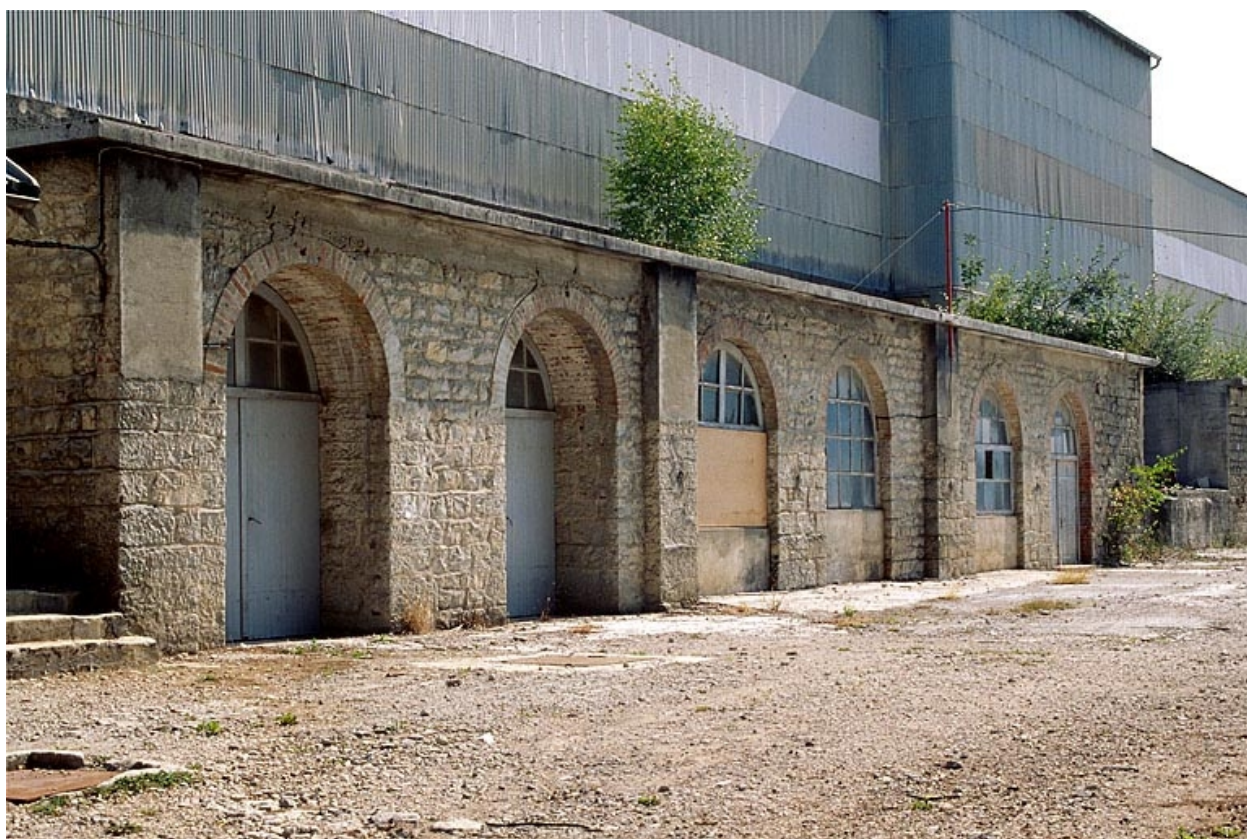
Baies cintrées des chambres d'extinction.
