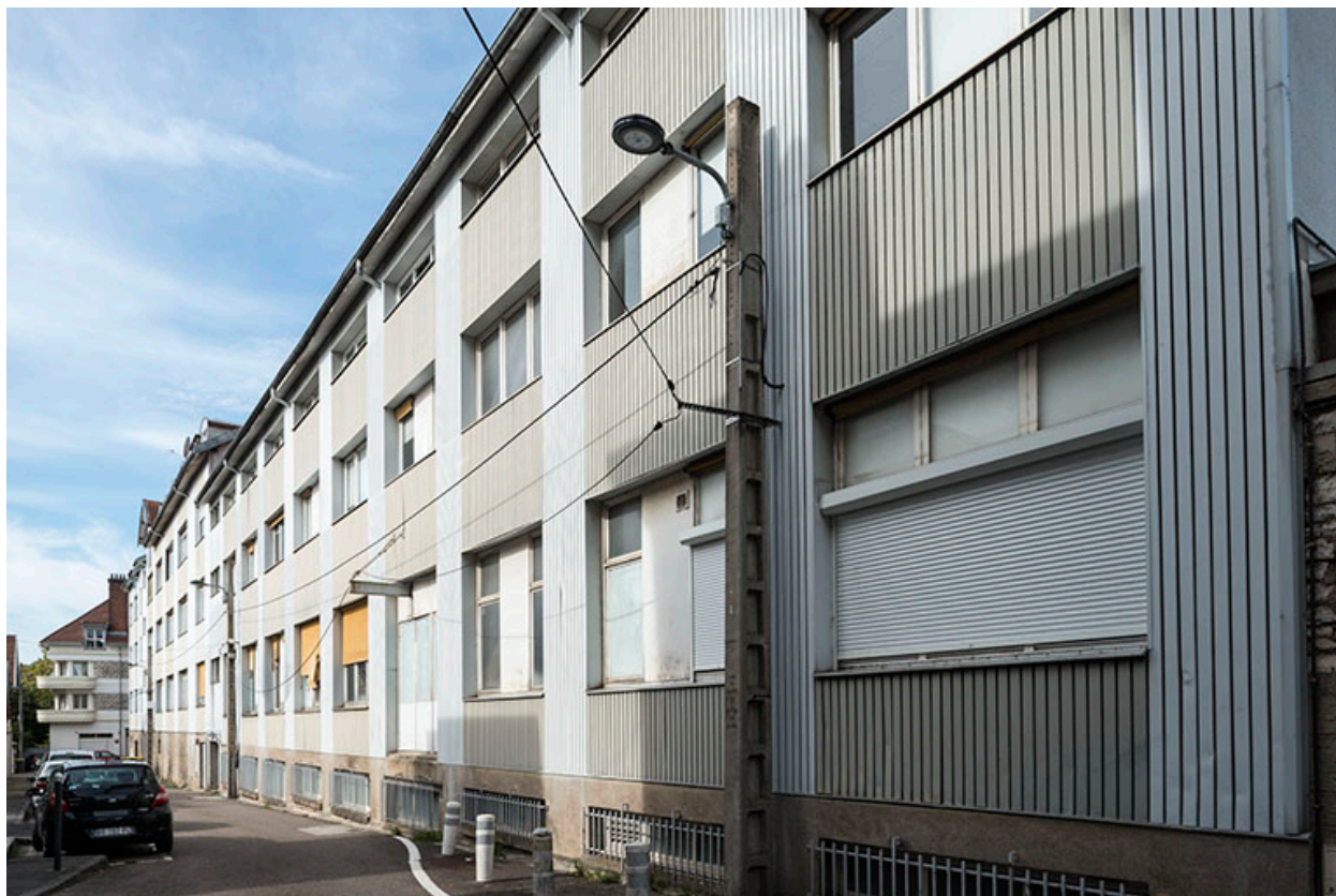
Façade du bâtiment sud.
