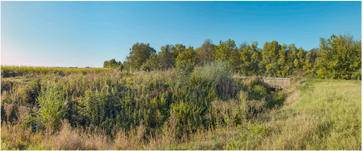
Le ponceau dans son environnement.
