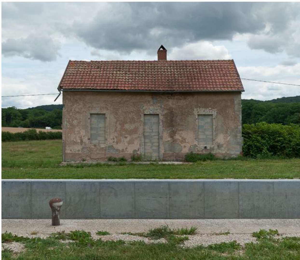
Vue de face de la maison éclusière.
