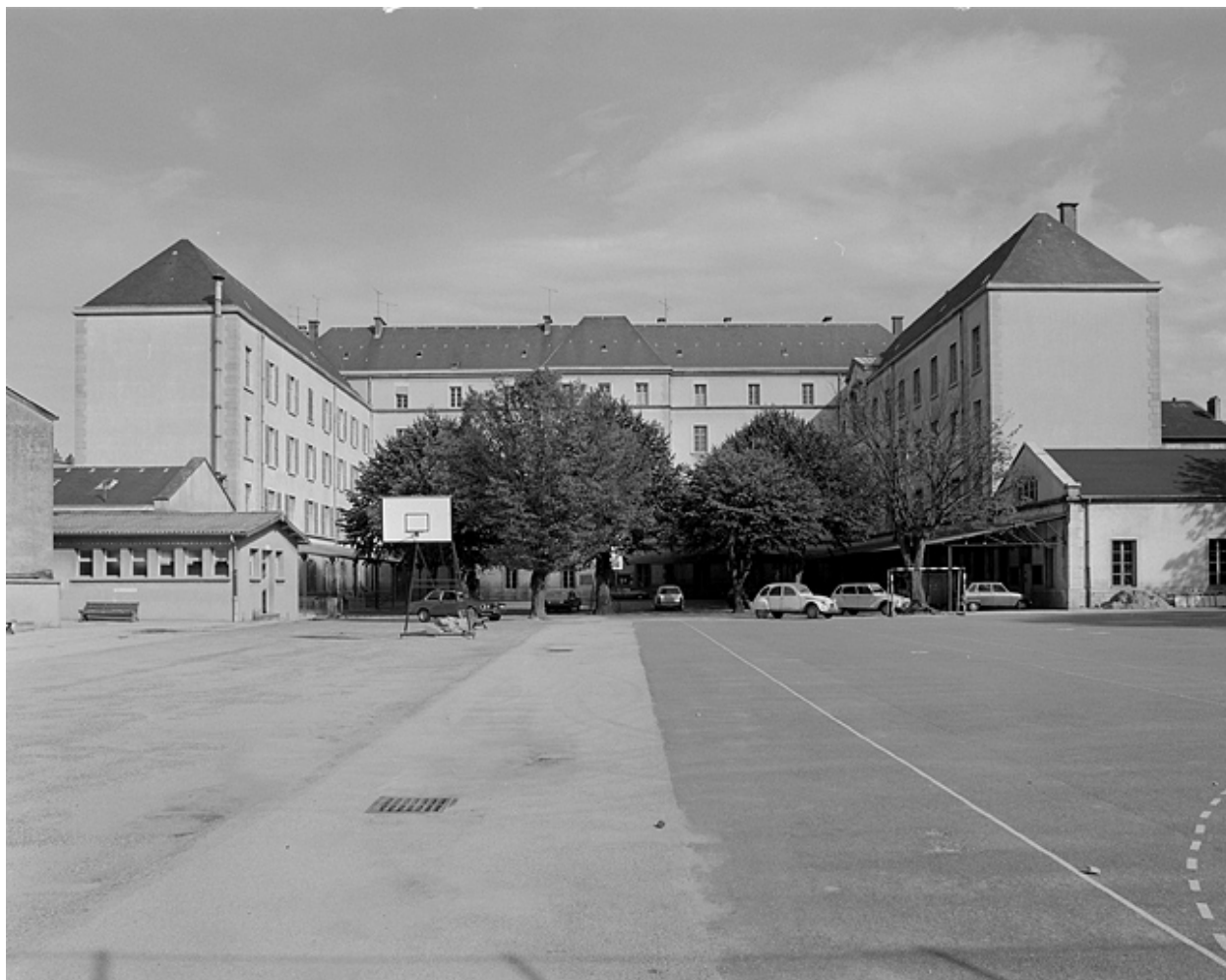
Façades des bâtiments sur la cour.
