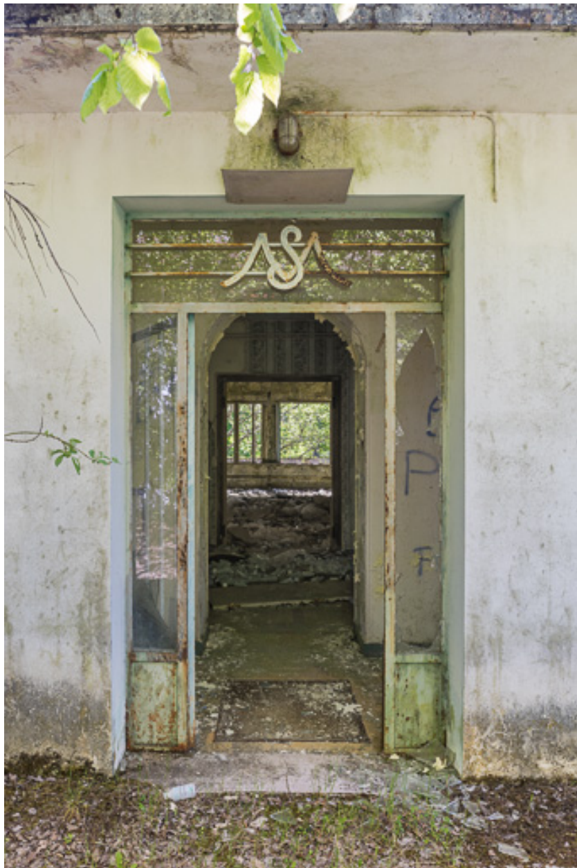
Bâtiment principal, façade postérieure, porte d'entrée.
