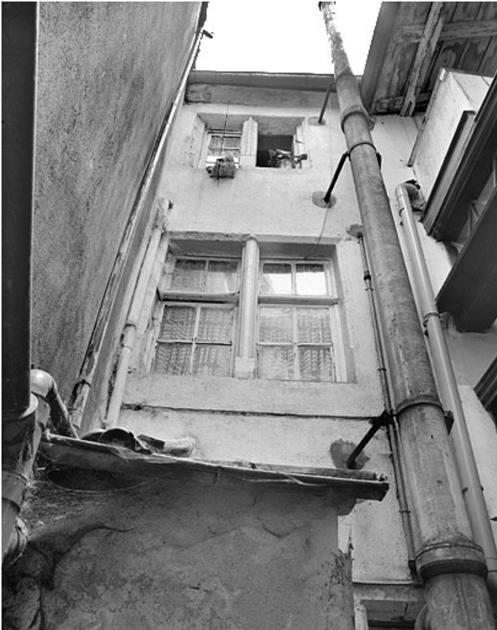
Façade sur cour du premier corps de bâtiment.
