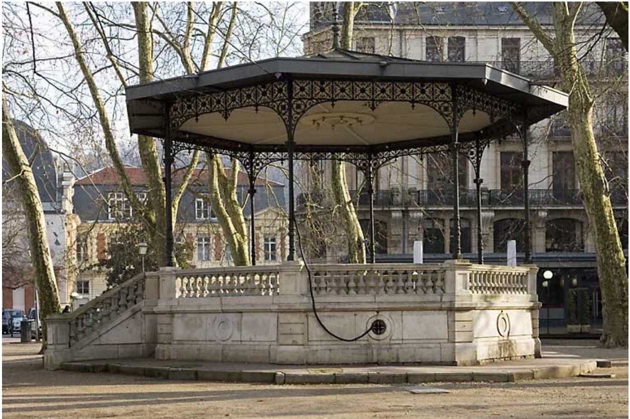
Vue d'ensemble du kiosque depuis la droite.
