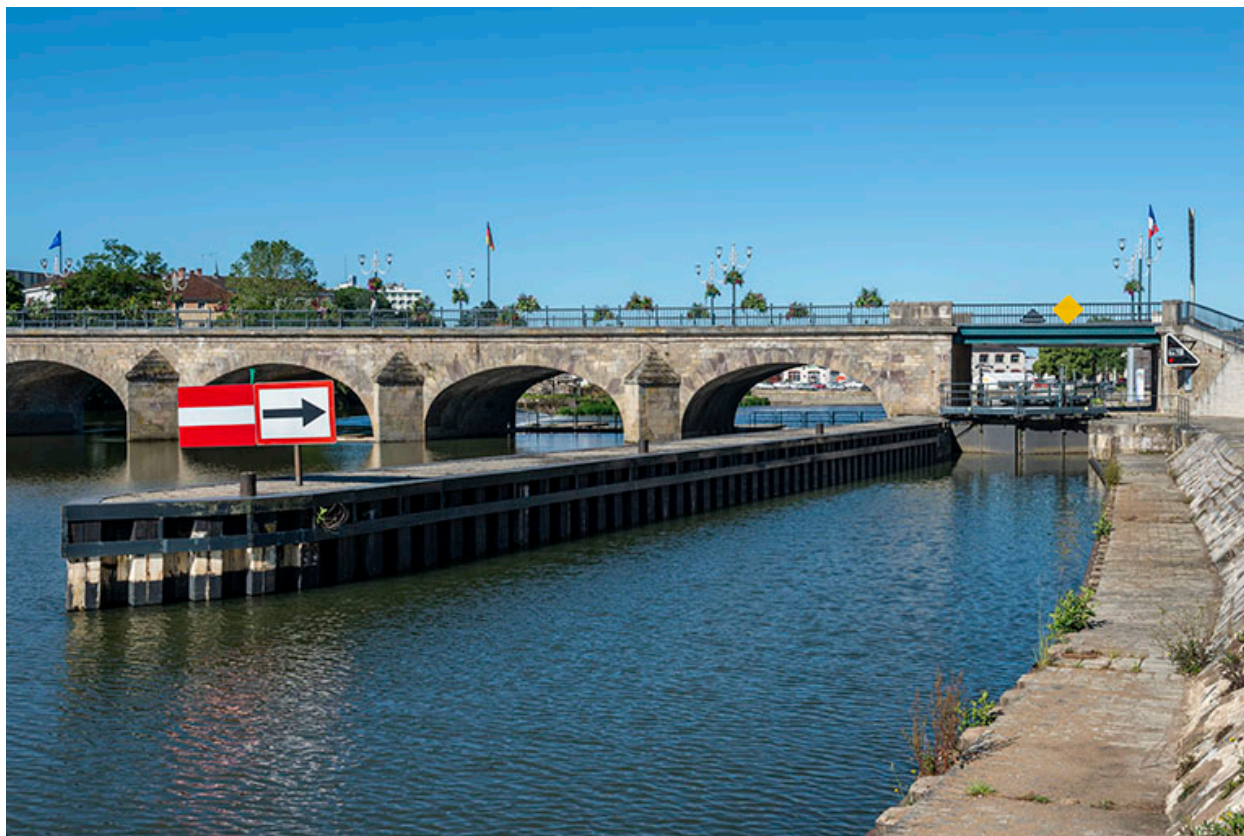
Vue amont de l'arche marinière à Gray.
