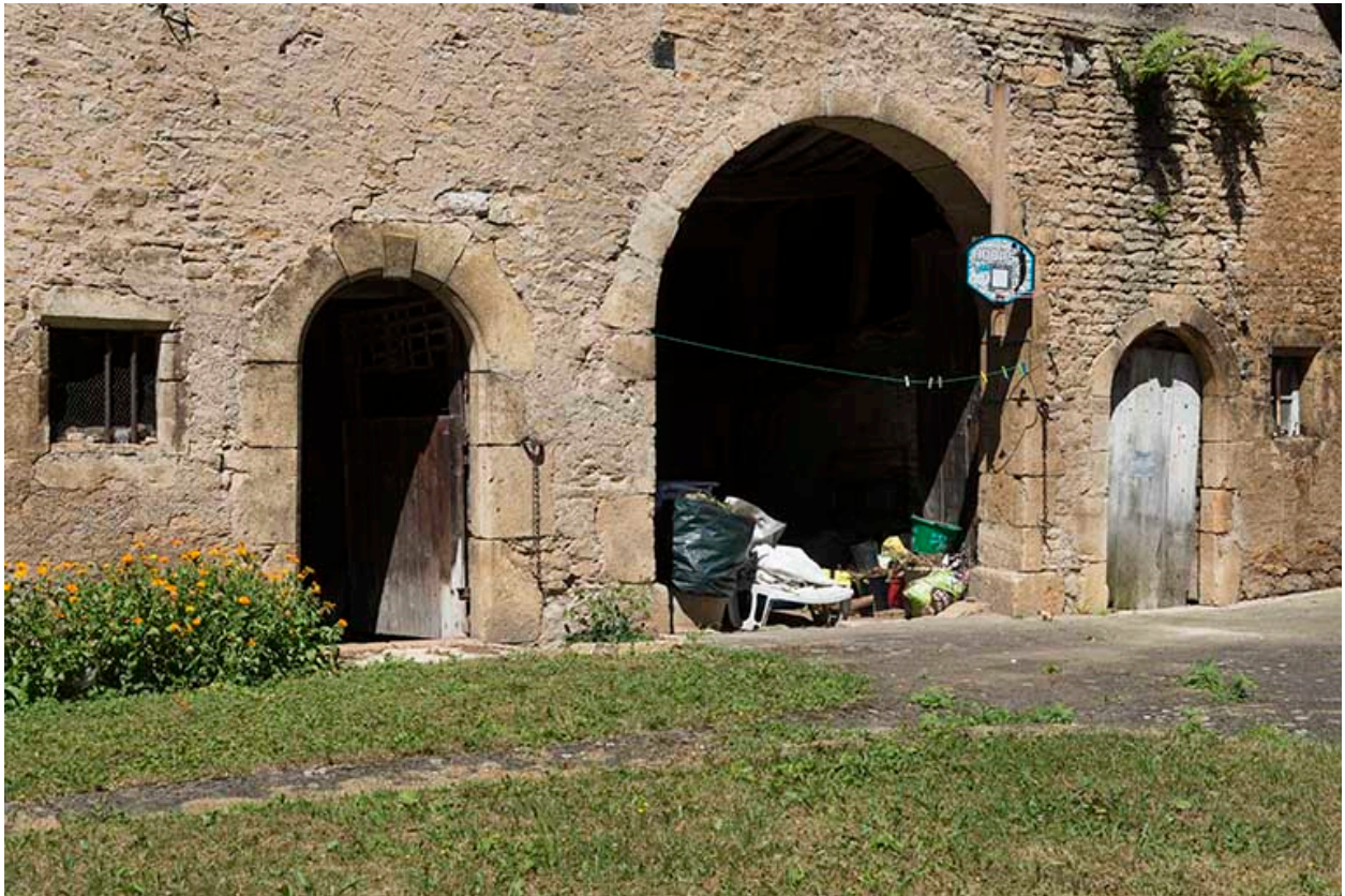
Portes de la remise.
