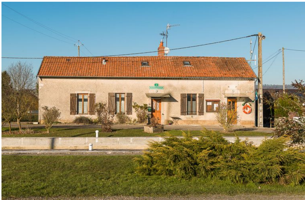
Vue de face de la maison éclusière.
