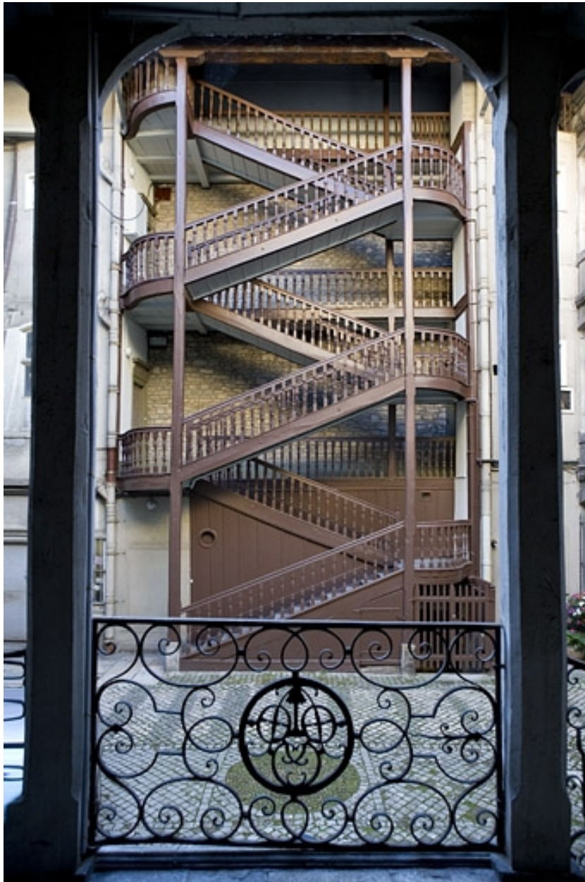
Vue de l'escalier à cage ouverte gauche, de face, depuis l'escalier droit.
