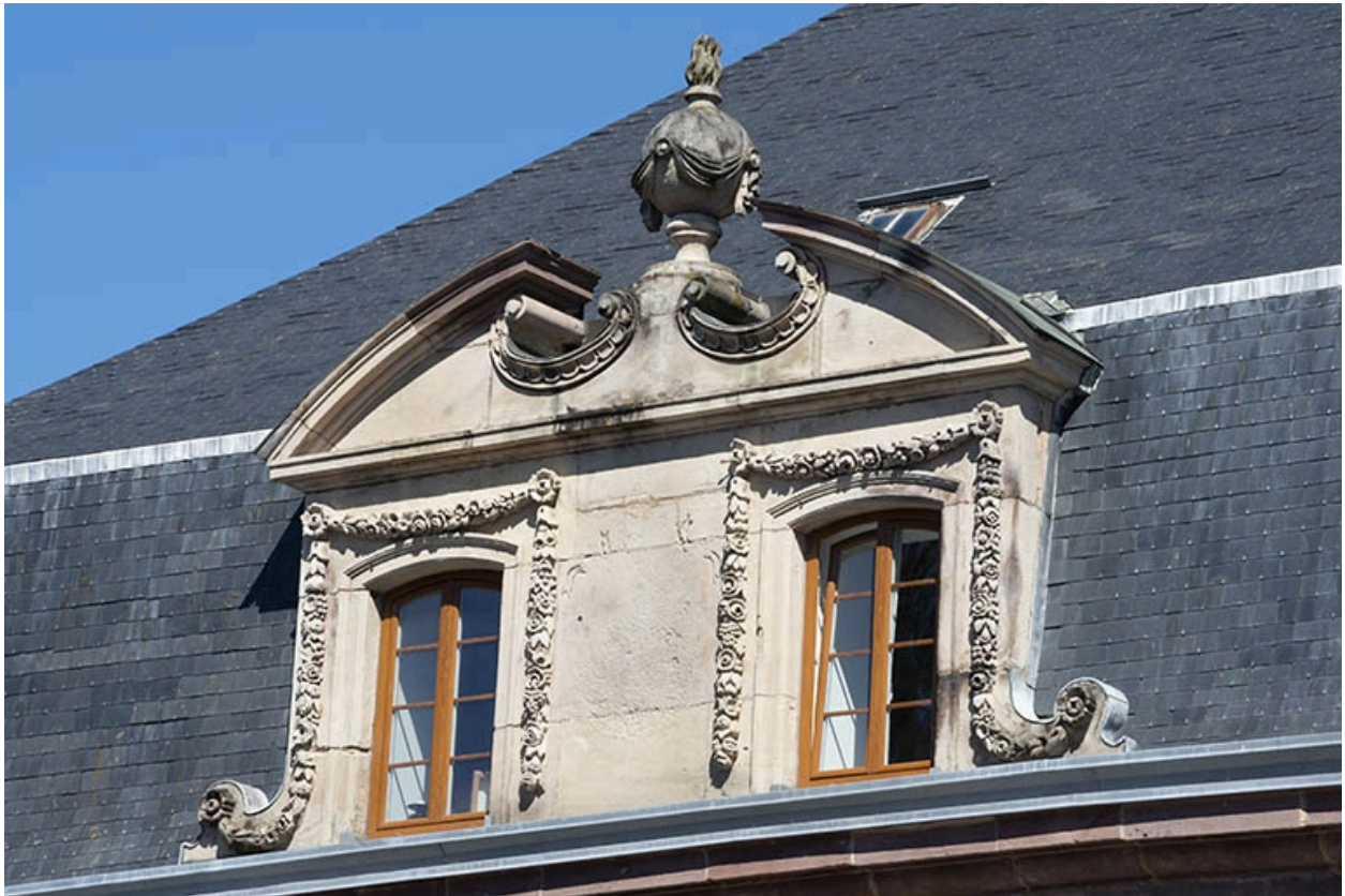
Maison Desgranges, lucarne sud.
